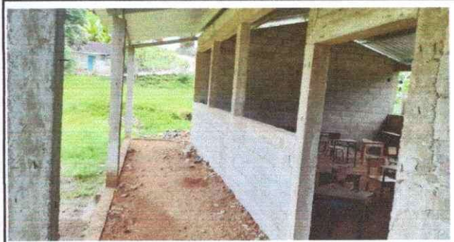
Foto 2: LE FALTA ENTORTADO Y PISO
