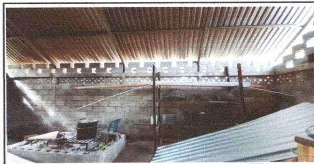
INTERIOR DE LA COCINA
