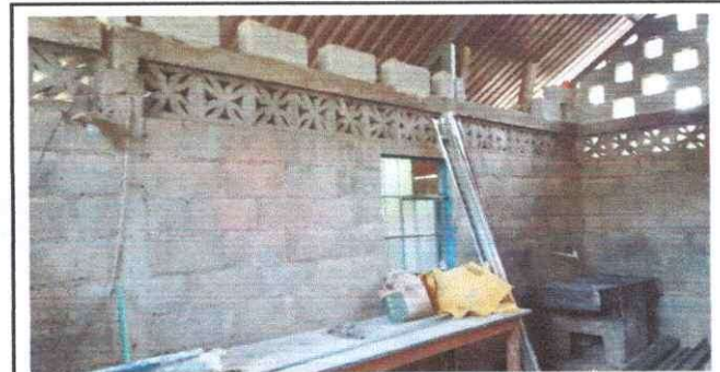
FALTA DE REPELLO EN LA COCINA
